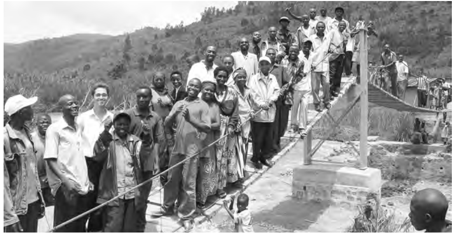
Eine 30 Meter spannende Seilbrücke über den Mukungwa Fluss ermöglicht den Anwohnern u.a. den Zugang zum Krankenhaus. Foto: Ingenieure ohne Grenzen e.V.
