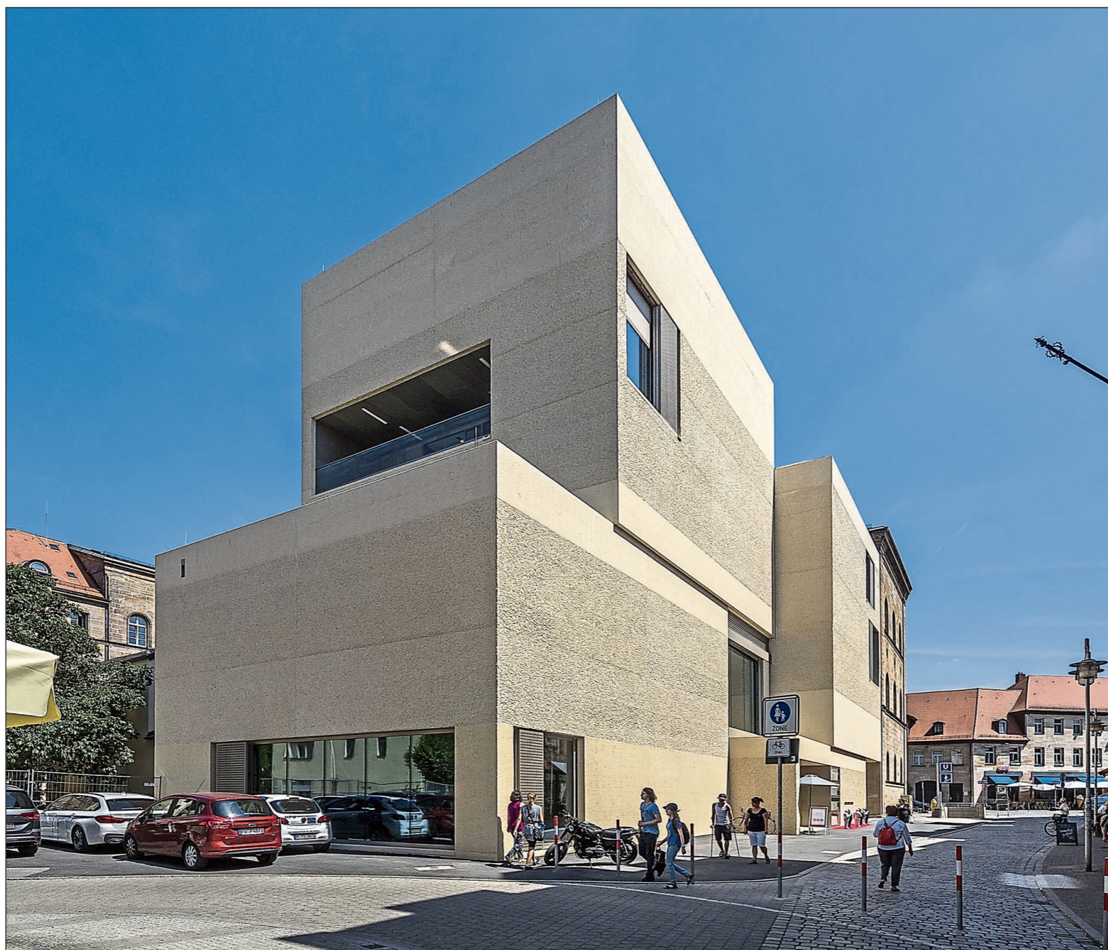
Der Neubau mit der Sichtbetonfassade von Westen aus gesehen.
